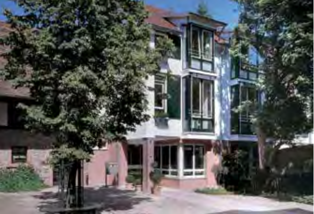
Blick auf den Eingang, der über den Hof zu erreichen ist
